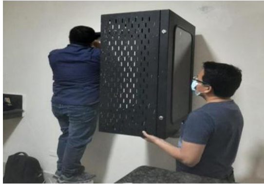
Ilustración 9. Instalación de gabinetes de comunicaciones
