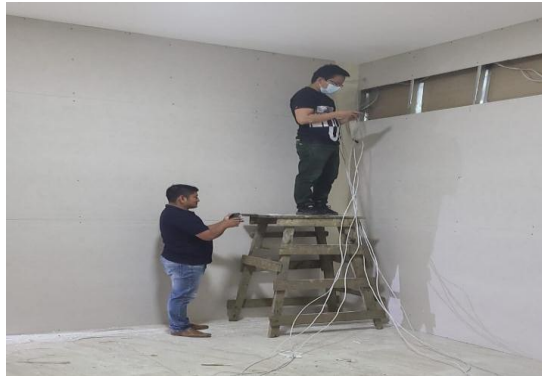
Ilustración 10. Despliegue del cableado
