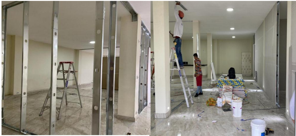
Ilustración 7. Estructura metálica para divisiones
